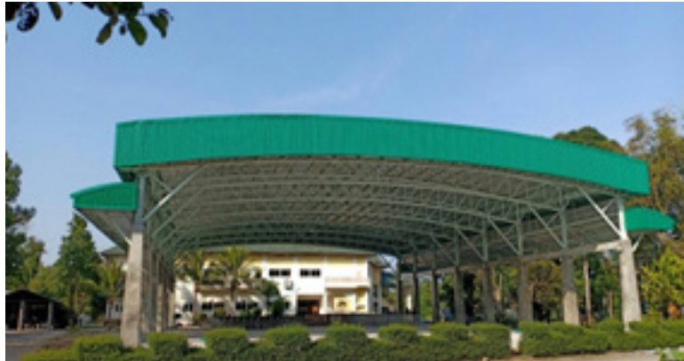
วิทยาลัยนาฏศิลป์พัทลุง ก่อสร้างลานเอนกประสงค์แบบมีหลังคา
