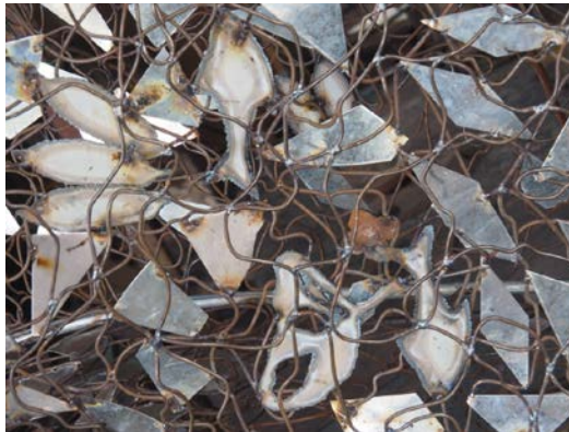
ภาพที่ 11 ขั้นตอนการดำเนินงาน การนำรูปทรงต่าง ๆ ที่เตรียมไว้ มาประกอบด้วยวิธีการเชื่อมต่อ ที่มา: ผู้วิจัย
