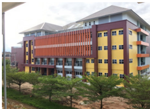
หลังก่อสร้าง
