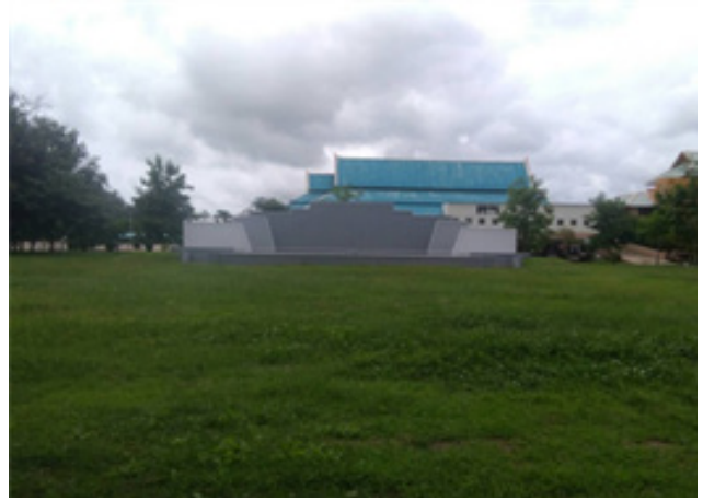
หลังก่อสร้าง
