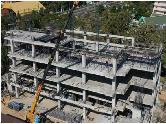
ระหว่างก่อสร้าง
