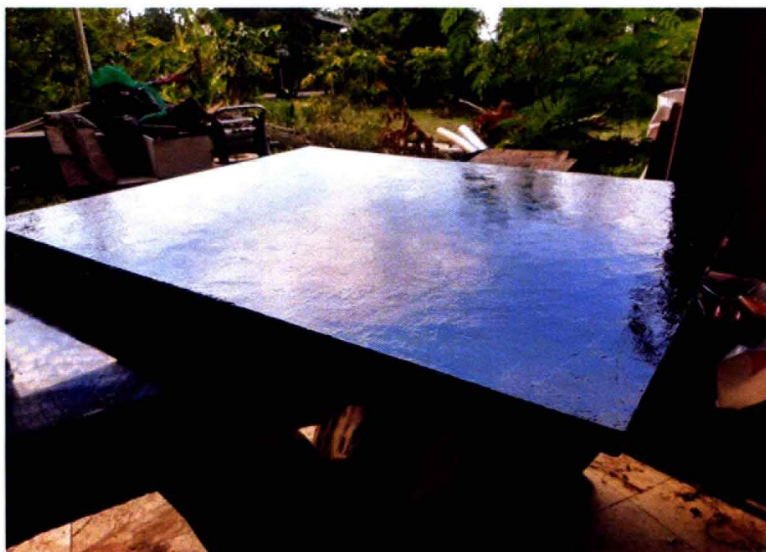
ภาพที่ 19 กระดานพื้นงานที่ทำเสร็จแล้ว
