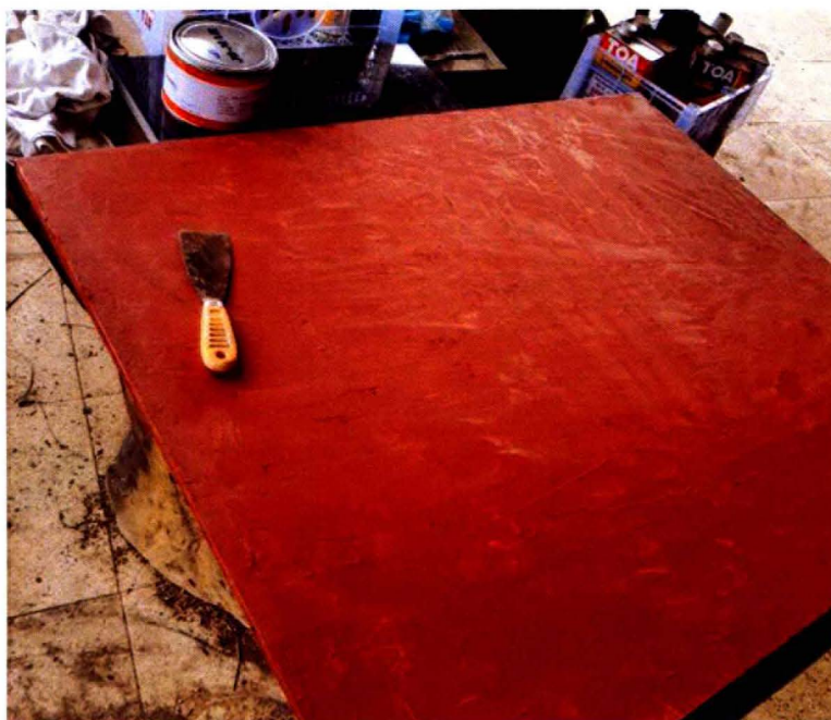
ภาพที่ 14 กระดานพื้นงานหลังจากทาสีโป้วจนเต็มแผ่น
