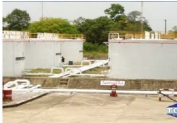
ถังเก็บน้ำมันเชื้อเพลิงบนดิน
