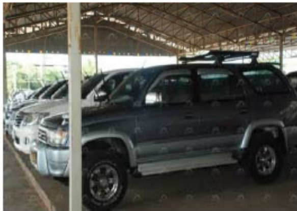
เตนท์โครงหลังคาเหล็กถาวร
