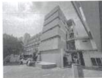
๓) ฟอร์ดหลังคาน้ำฝนภายนอกอาคารของ ท่าลิโหลงหนง
