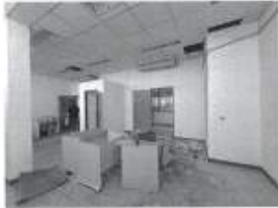
33 ห้องคอมพิวเตอร์ เครื่องรับอากาศ คอนกรีตแข็ง
