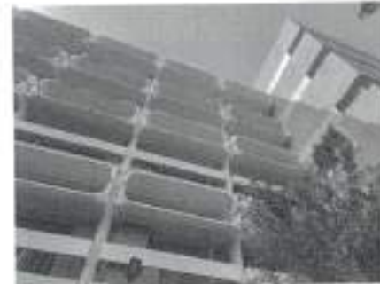
๒) ฟอร์ดหลังคาน้ำฝนภายนอกอาคารของ ท่าลิโหลงหนง
