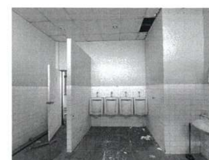
1 ร้อยตอนโถส้วมชาย, ตะแกรงระบายน้ำ
