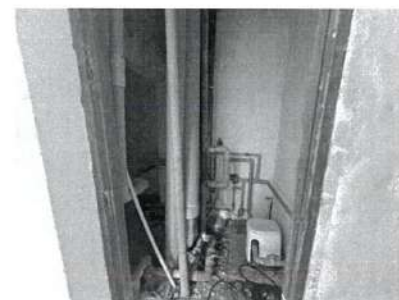
2) รีดอนระบบท่อน้ำ-น้ำเสีย
