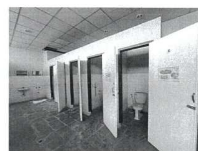
1 ร้อยตอนโถส้วม (WATER CLOSET, FLUSH TANK) พร้อมอุปกรณ์, โคมไฟ Downlight
